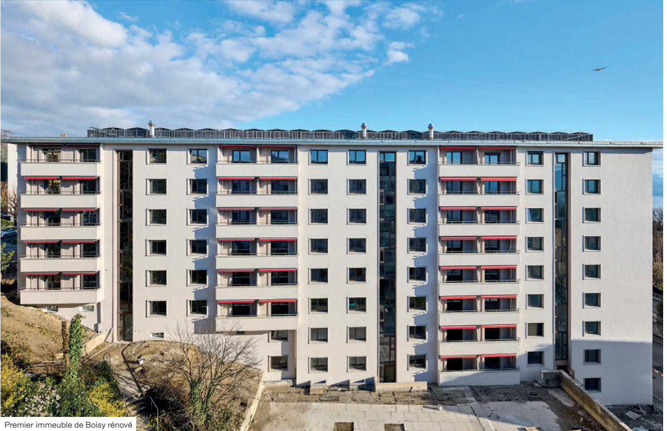
Premier immeuble de Boisy rénové
