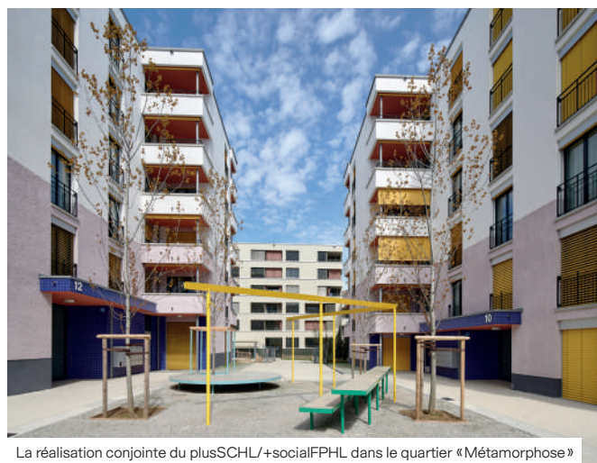
La réalisation conjointe du plusSCHL/+socialFPHL dans le quartier «Métamorphose»
