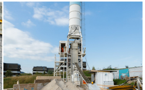
Crédit photo ADV Constructions/Créacom
