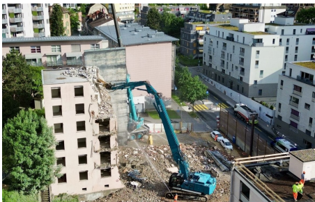
Chantier de Crêtes en mai
