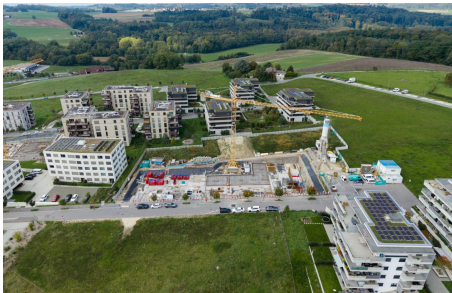
Crédit photo ADV Constructions/Créacom
