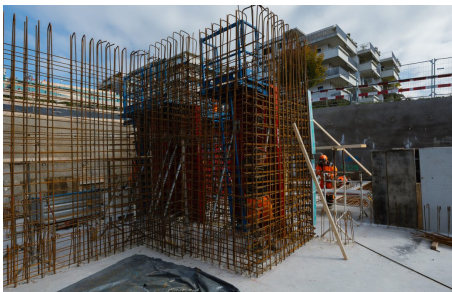
Crédit photo ADV Constructions/Créacom
