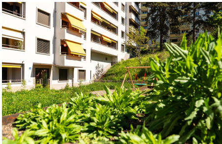
La façade rénovée de la deuxième barre d'immeuble
