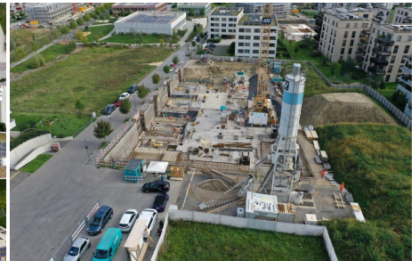
Crédit photo ADV Constructions/Créacom
